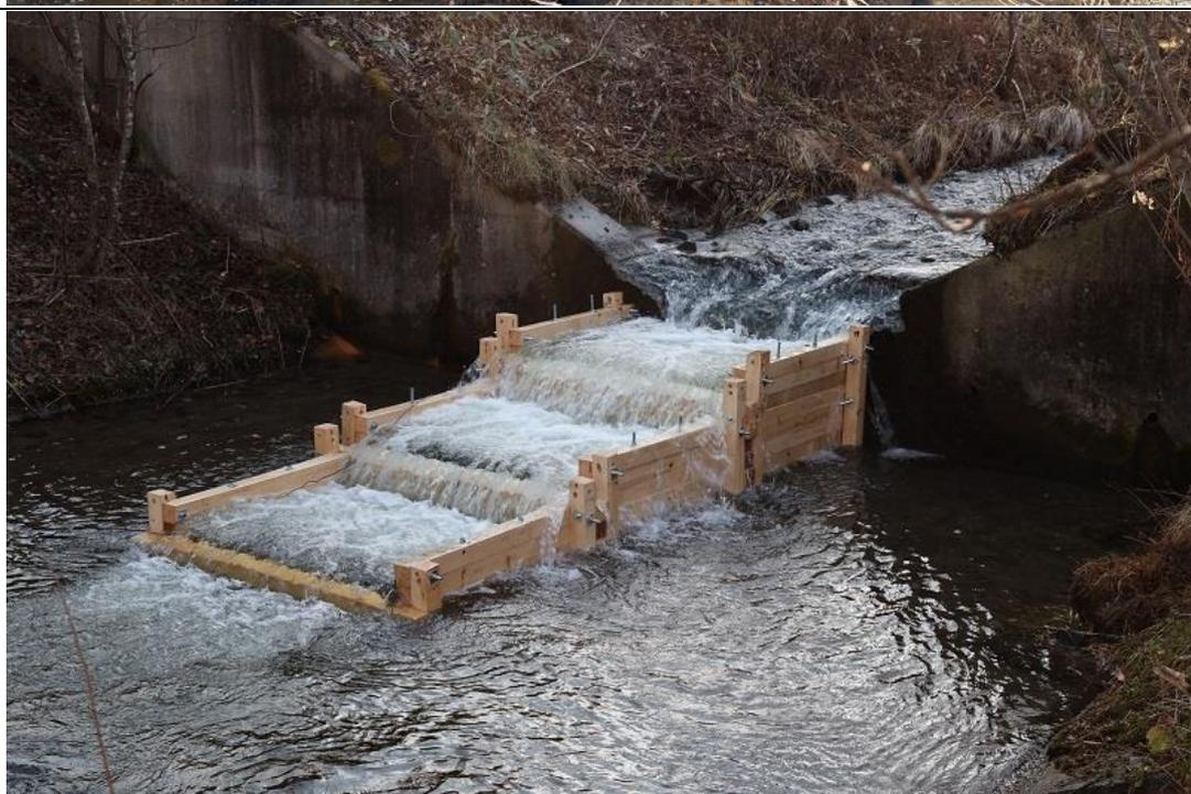
堤体 30 cm 切り下げ、上流護床連節ブロック一部撤去、下流側木組階段式魚道設置
