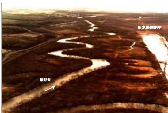
写真 3-1 新水路工事中（1976 年撮影）
