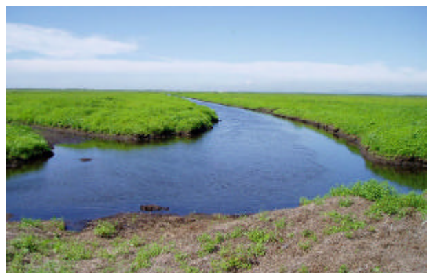
写真 湛水試験終了後の試験地の状況 雪裡樋門上より撮影 (平成 16 年撮影)
