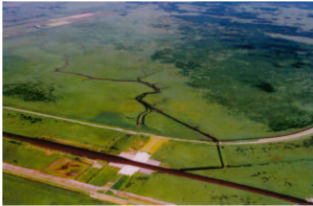
写真 3-1 湛水前の状況(平成 13 年撮影)
