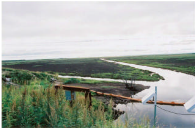
写真 3-3 排水後の状況(平成 15 年撮影)
