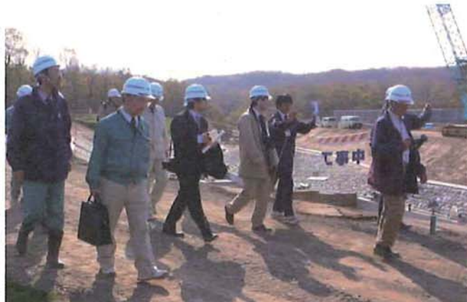
▲土砂流入対策(久著呂川)実施箇所(中久著呂 河道安定化対策)
