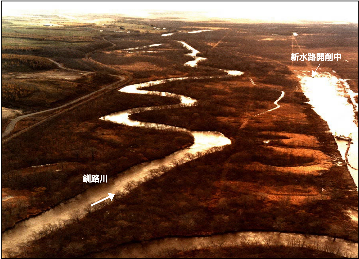
写真 2-1 新水路工事中（昭和 51 年撮影）
