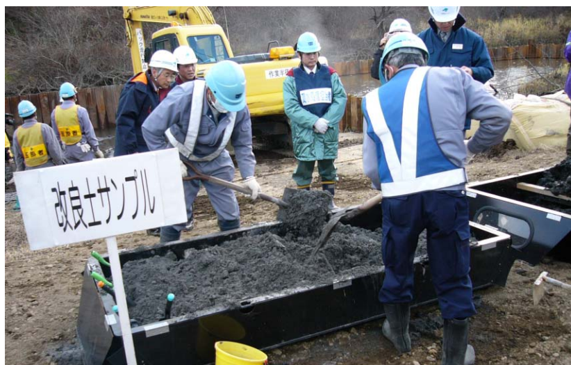
泥土改良の状況
