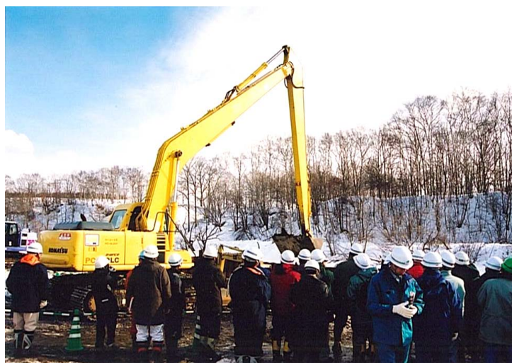
試験掘削の状況
