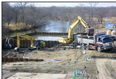
締切内の掘削状況
