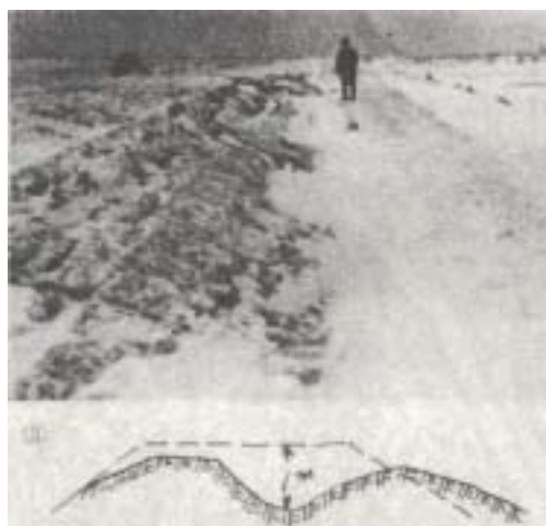
写真 2-10 十勝沖地震被災状況
