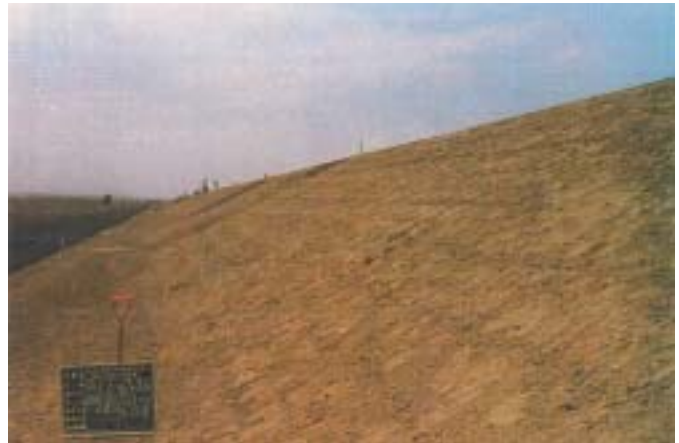
写真 2-8(2) 左右岸築堤の嵩上げ(右岸)
