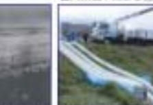
▲ポンプ車による内水暴発
