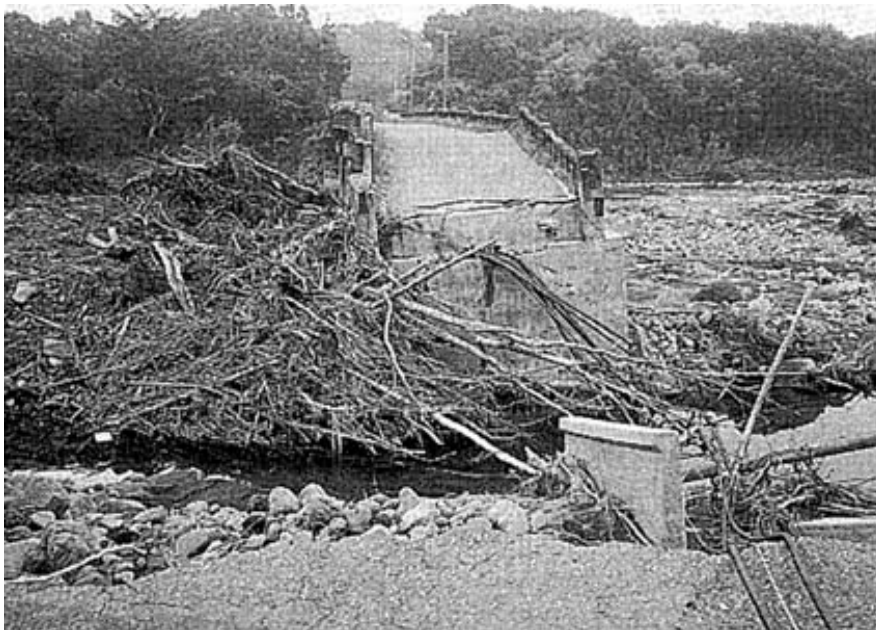
図 2-41 橋梁による水位上昇の概念
