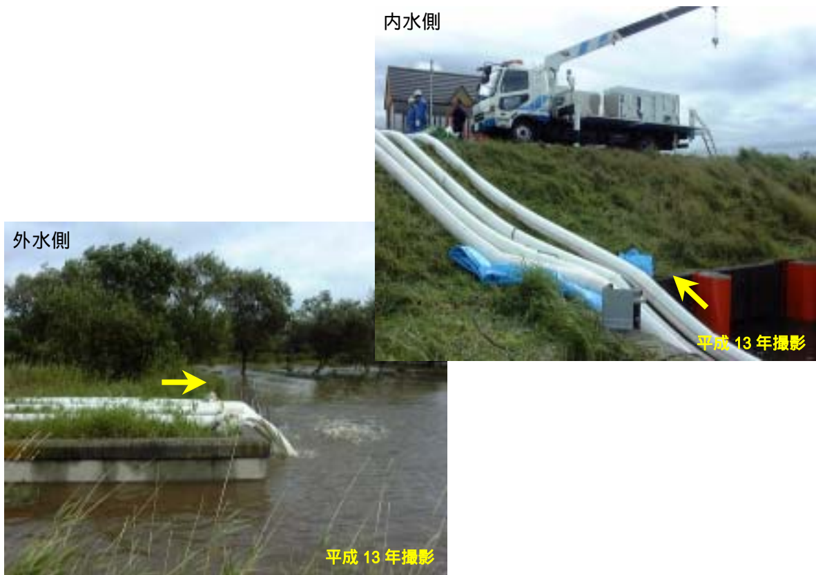
写真 2-2 排水ポンプ車稼動状況（釧路川下オソベツ樋門；KP37.6 付近）
