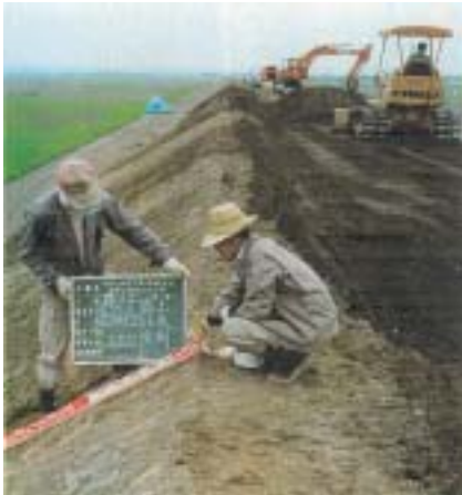
写真 2-8(1) 左右岸築堤の嵩上げ(左岸)
