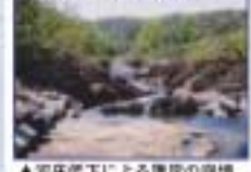
▲河床低下による護岸の陥没
