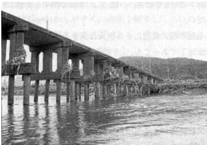
写真 2-4 河床低下により危険な状態にある橋梁の例
