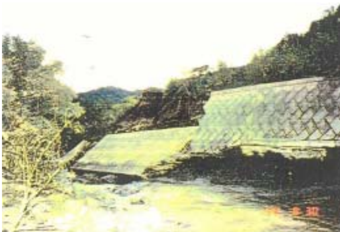
写真 2-5 護岸基礎部の河床低下による護岸被災事例
