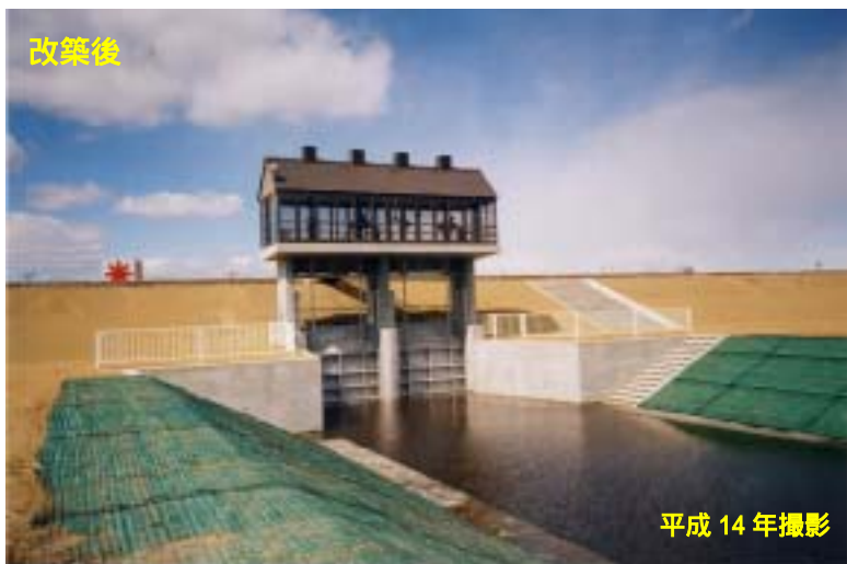
写真 2-1 昭和樋門 (KP2.8 右岸) の改築
