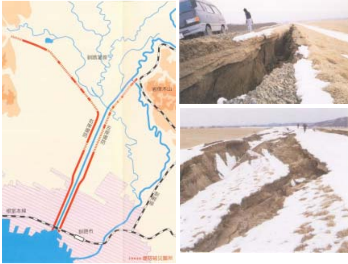
図 2-21 釧路沖地震（1993 年）における堤防被災箇所とその状況
