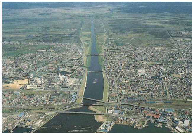
新釧路川下流域、直線化された区間であり、河川敷は公園等に利用される。
