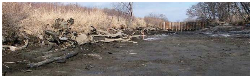
■沈木設置状況
