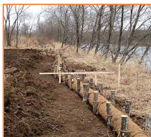
■濁水流出防止工設置状況
