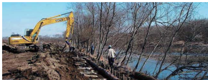
右岸残土撤去状況
