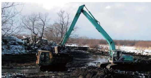
旧川掘削状況
