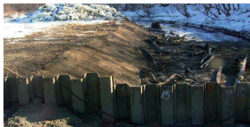
■沈木設置状況
