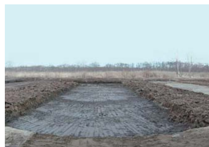
■右岸残土撤去箇所のヨシ表土の敷き均し状況
