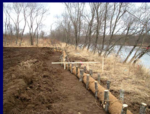
濁水流出防止工設置状況
