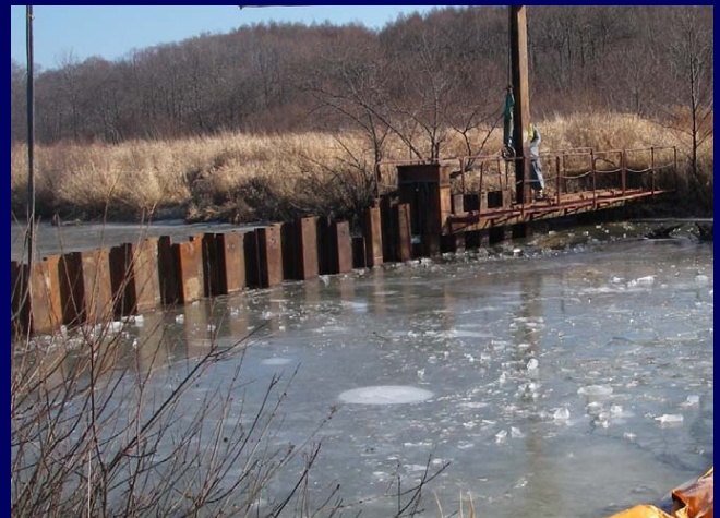
仮締切矢板の打ち込み状況
