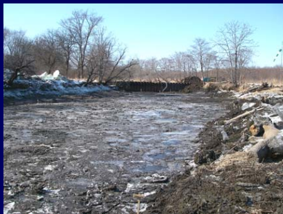
底泥堆積状況
