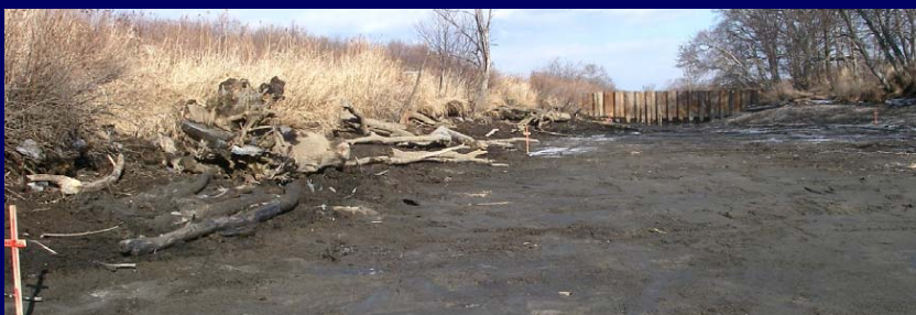
沈木設置状況
