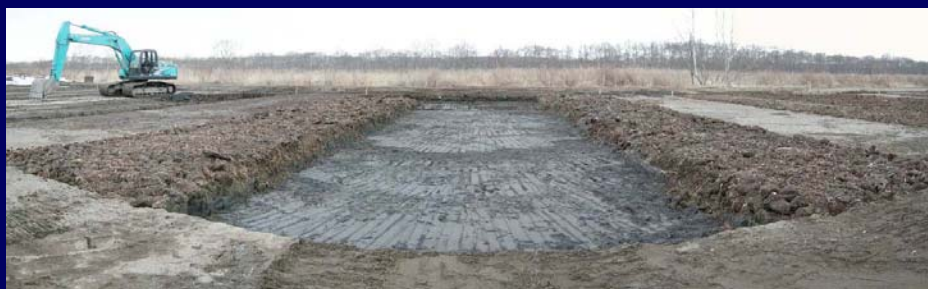
ヨシ表土の敷き均し状況
