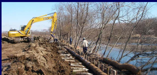
右岸残土撤去状況
