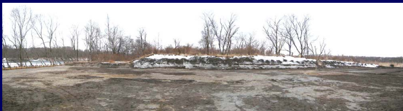
右岸残土撤去状況
