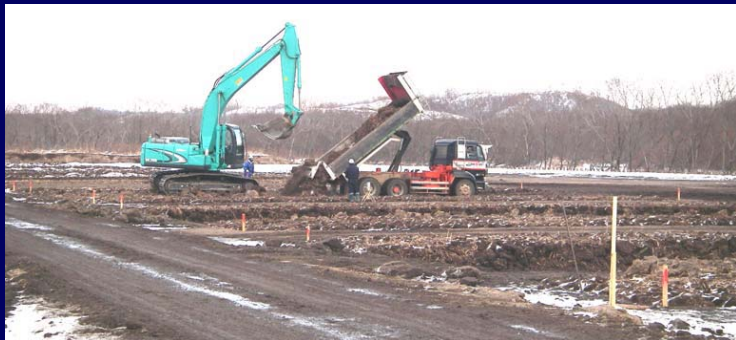
ヨシ表土の運搬、敷き均し
