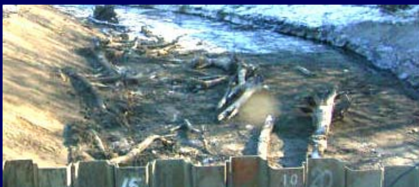
沈木設置状況
