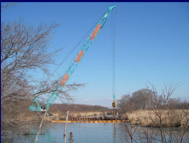
仮締切矢板の打ち込み状況
