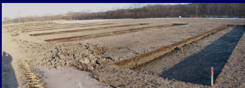
ヨシ移植用窪地の掘削
