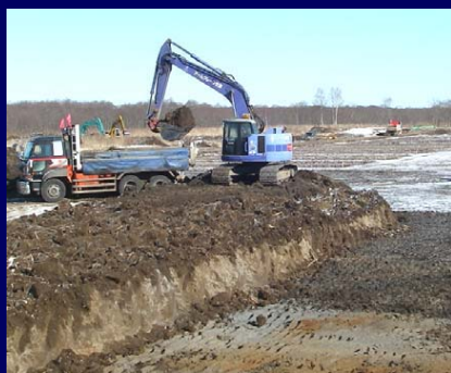
右岸残土撤去作業状況
