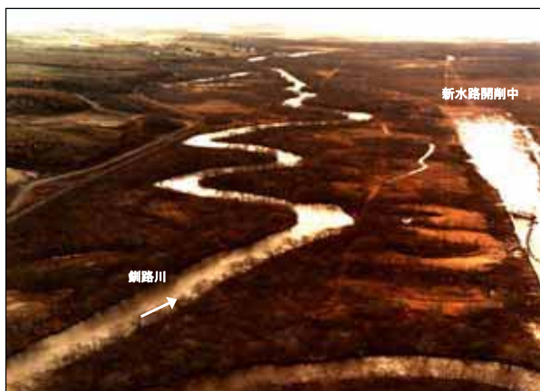
写真 3-1 新水路工事中（昭和 51 年撮影）
