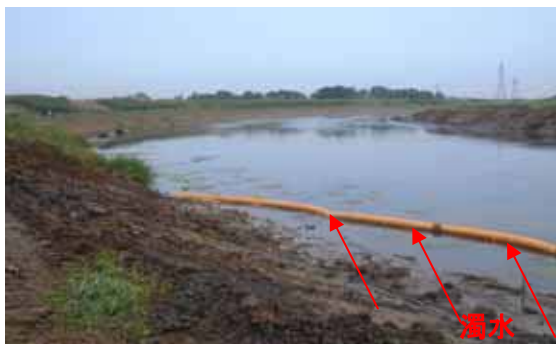
シルトフェンスによる濁水流出・拡散の防止
