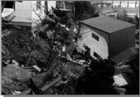
斜面崩壊による家屋の被害
