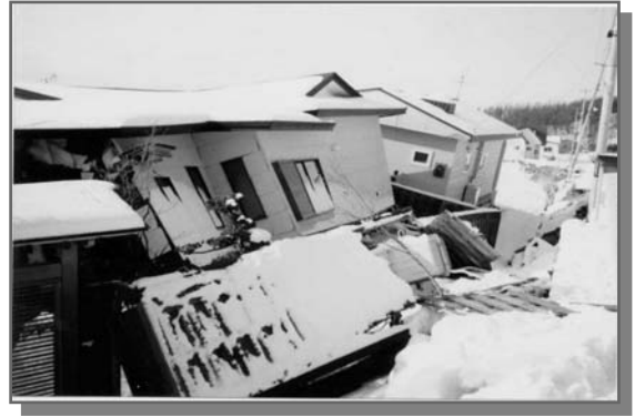
地盤沈下による家屋の被害
