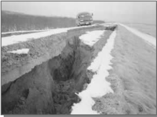
天端が陥没した釧路川の築堤
