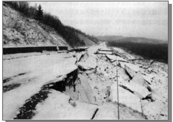
道路盛土の崩壊
