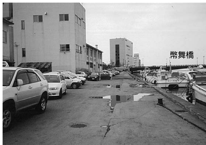
写真 -1-2 幣舞橋上流左岸の状況 (平成10年撮影)
