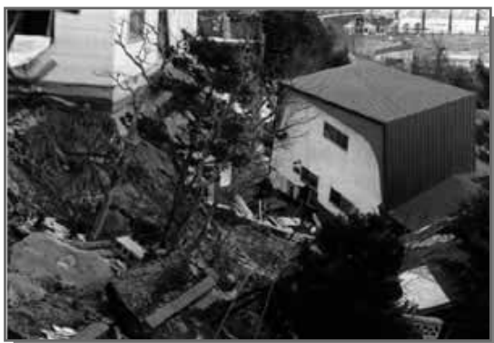
斜面崩壊による家屋の被害
