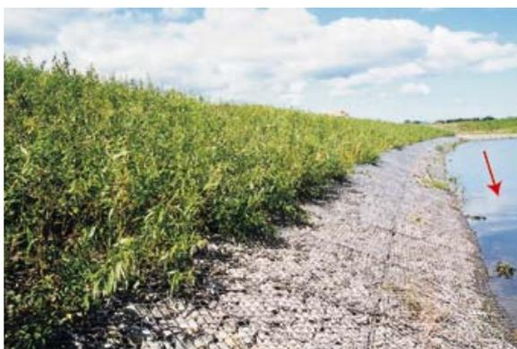
写真 2-3 多孔質なタイプの河岸安定化対策工
