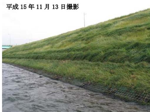
写真 2-4 植生マットによる河岸安定化対策工
