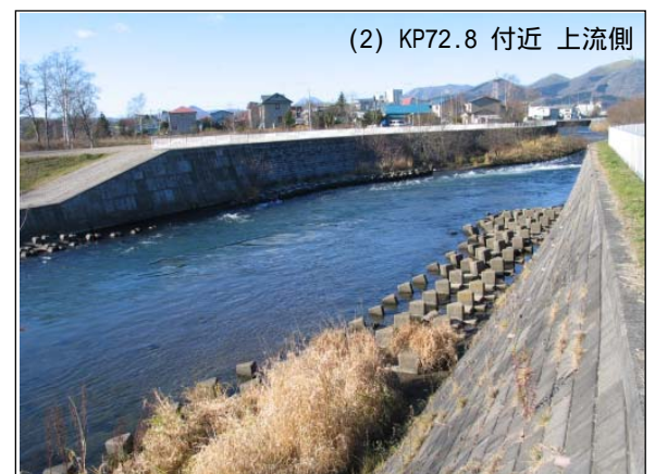
写真 2-1 帯工による河床低下対策の状況
