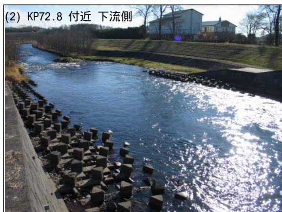
写真 2-1 帯工による河床低下対策の状況
