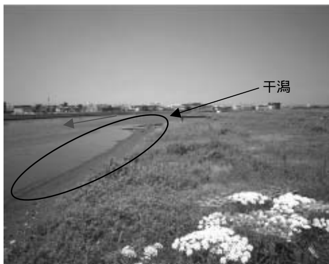
写真 1-10 JR 橋より上流左岸より上流の干潟の状況
