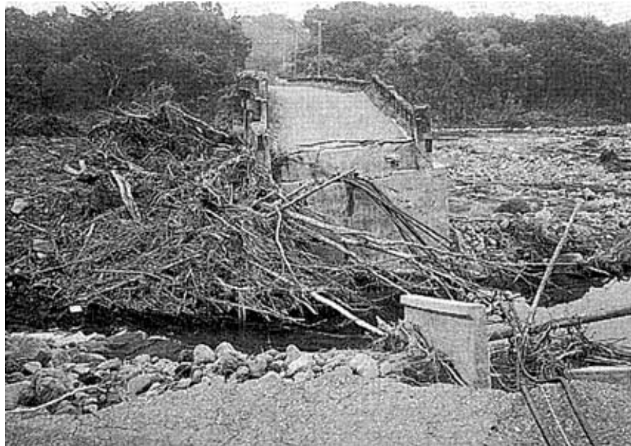
写真 1-8 橋梁による流下阻害と橋梁決壊
