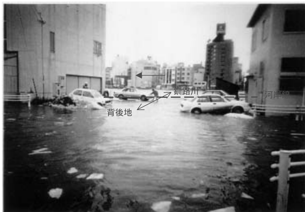
写真 1-6 堤防未整備による溢水の状況(H6.2.22 幣舞橋上流左岸)
