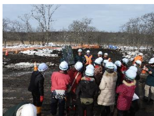
自然再生事業地 工事現場見学
