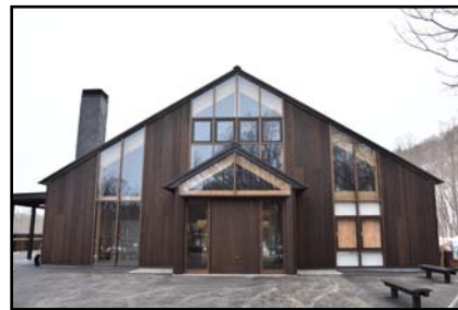
建設中のビジターセンター
