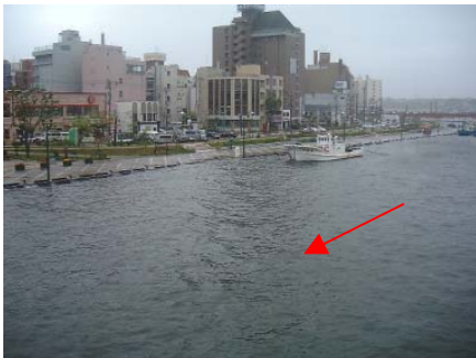
河道水位上昇の様子(16:30 頃) (幣舞橋上流施工済区間)
