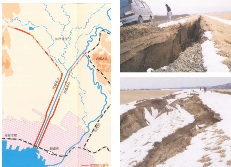
図2-13 平成5年(1993年)1月15日 釧路沖地震における堤防被災箇所とその状況
