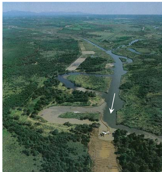
沼幌新水路浚渫工事
