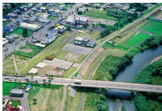
標茶地区河川防災ステーション
