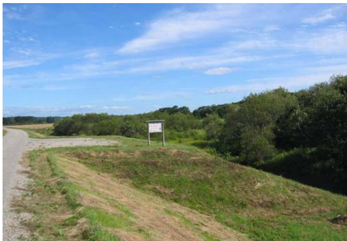
側帯全景(上流側～下流側)
