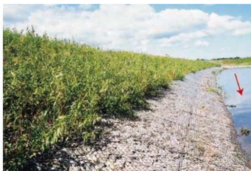
AGS工法による護岸整備
