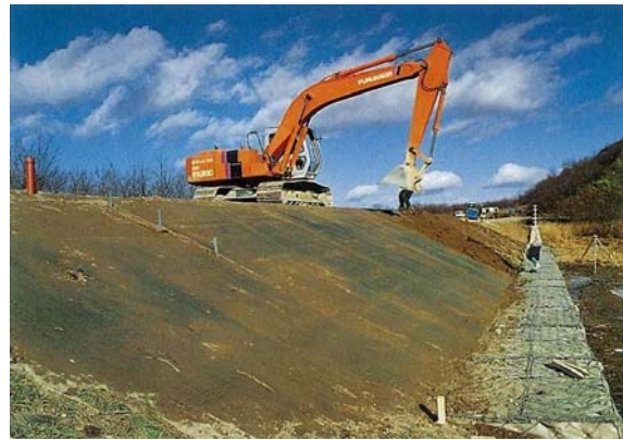
復旧工事状況
