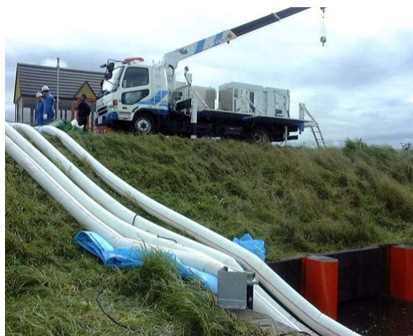
ポンプ車による内水排除の状況
