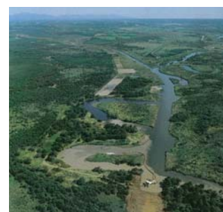
沼幌新水路浚渫工事の様子
