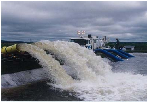
内水排除訓練
