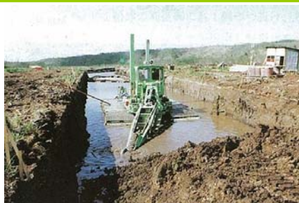
オソベツ川浚渫工事
