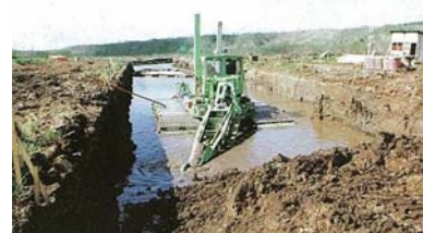
オソベツ川浚渫工事の様子
