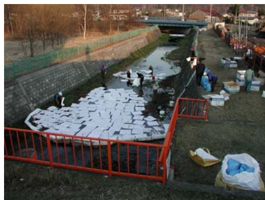
油分の除去状況
