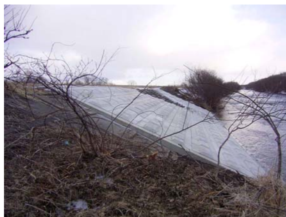
既設護岸の補修事例
