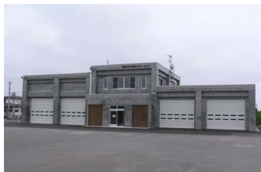
標茶地区河川防災ステーション
