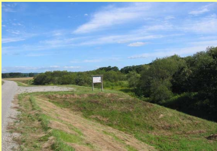
側帯全景(上流側～下流側)
