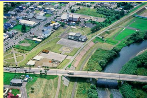
標茶地区河川防災ステーション
