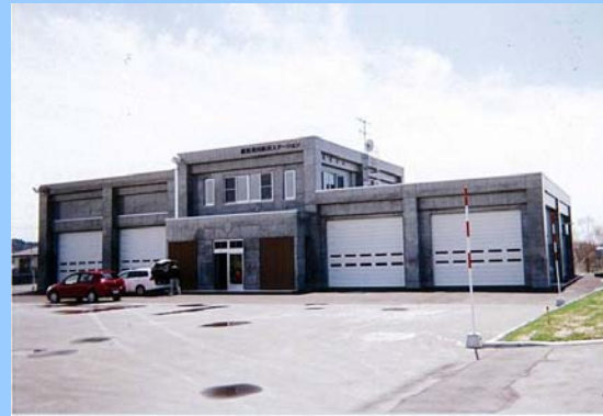
標茶地区河川防災ステーション
