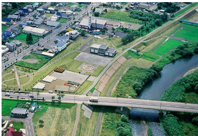
標茶地区河川防災ステーション
