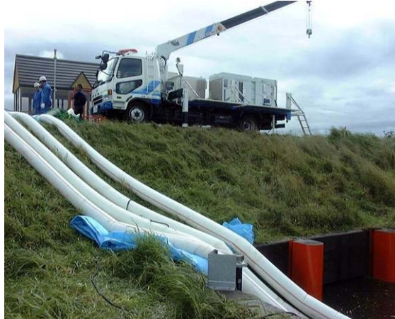
ポンプ車による内水排除の状況
