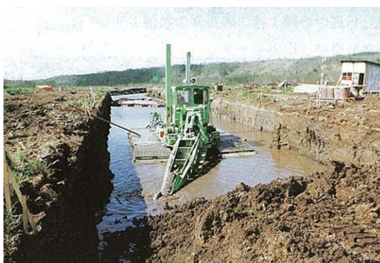
オソベツ川浚渫工事
