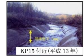
平成7年と13年の河川縦横断形状を比較し、その期間における対策箇所での河床低下量を把握するとともに、土砂発生量を推測した。
