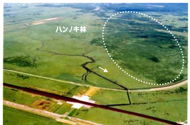
現在の雪裡樋門地区
