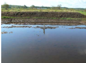
施工後2ヵ月 (H21.9月)
