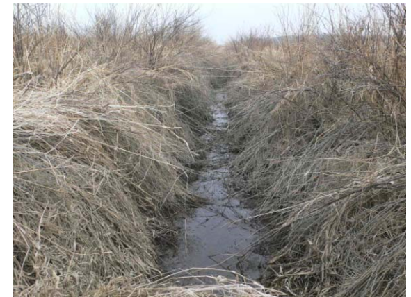
未利用排水路
