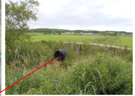
⑲: 農地側横断管渠
