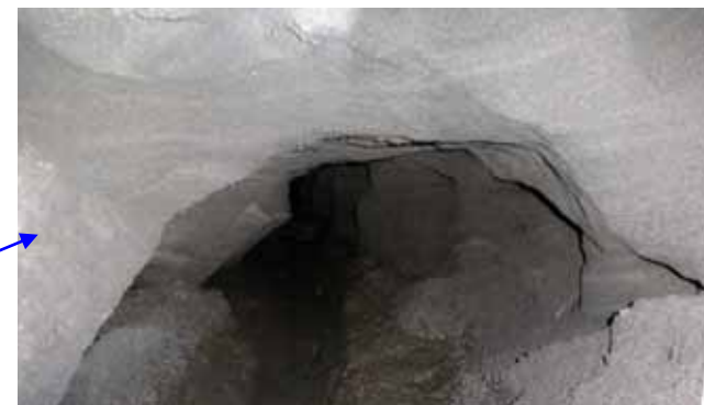
湧水地点の内部状況
