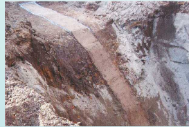
図20 遮水壁施工断面
