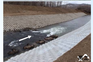
排水路合流部沈砂池
