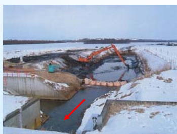
重機による土砂上げ状況（シロンド排水路）
