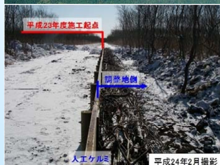
①上流側から下流方向を望む
