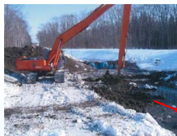
重機による土砂上げ状況（ルルラン1号排水路）
