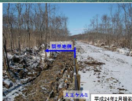
②下流側から上流方向を望む
