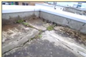
屋上防水押えコンクリートの損傷
