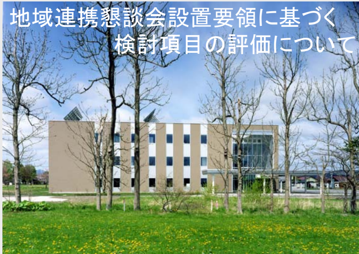
北海道開発局営繕部営繕整備課 八雲地方合同庁舎 地域連携懇談会(第8回) 1
