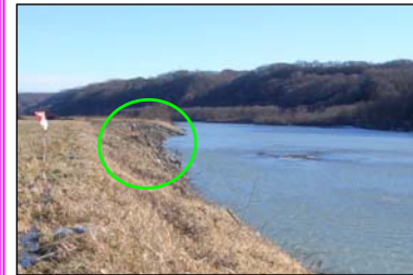
護岸のない河岸 ○の部分がけずられている
