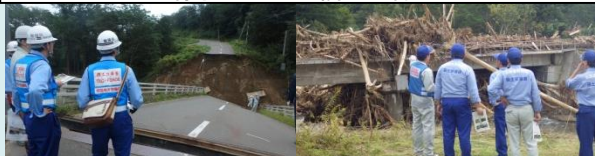
帯広市明星橋(四国地整班)
