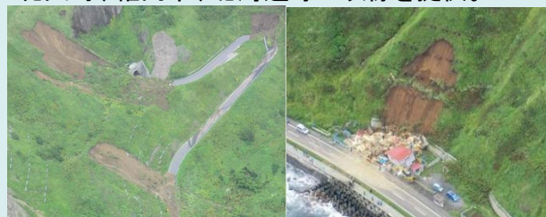
道道元地香深線被災状況
