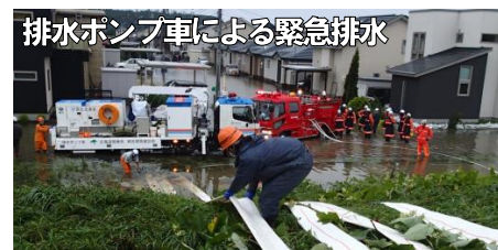
応急対策【被害拡大防止】
