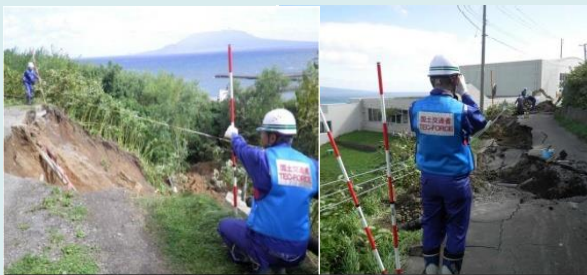
礼文小学校被災箇所状況調査
