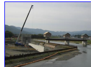
頭首工の整備 【空知川頭首工】
