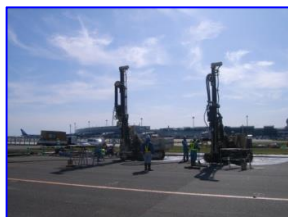
空港の液状化対策 【新千歳空港】
