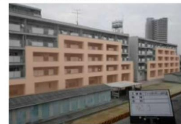
▲外付けフレーム耐震補強
