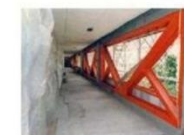
鉄骨ブレースによる壁の補強
