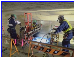
空港施設の耐震補強 【函館空港】
