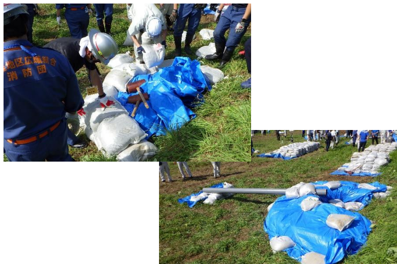
月の輪工法実施状況
