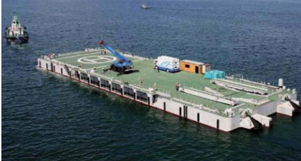
広域防災フロート全景
