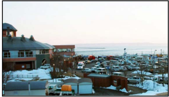
写真 住民・道路利用者の避難場所となった道の駅「厚岸グルメパーク」(H23.3.11)
