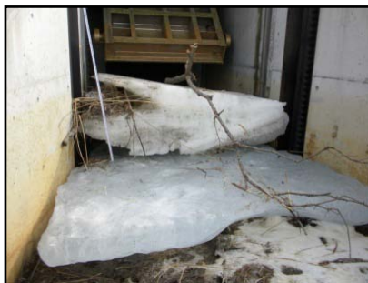
写真 樋門に浸入した氷（十勝川） (写真提供：寒地土木研究所寒地河川チーム)
