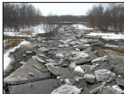
写真 樋門に浸入した氷（十勝川） (写真提供：寒地土木研究所寒地河川チーム)
