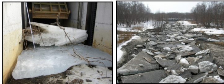
写真 樋門に浸入した氷（十勝川） 写真提供：寒地土木研究所寒地河川チーム
