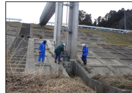
被災状況調査班 (河川樋門の被災状況調査)
