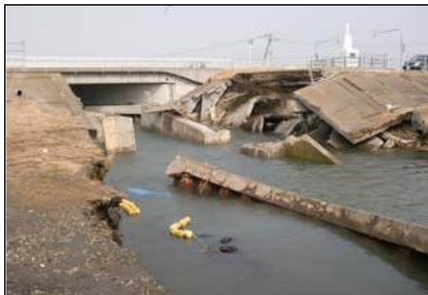
橋梁脇の堤防決壊 (霧多布)
