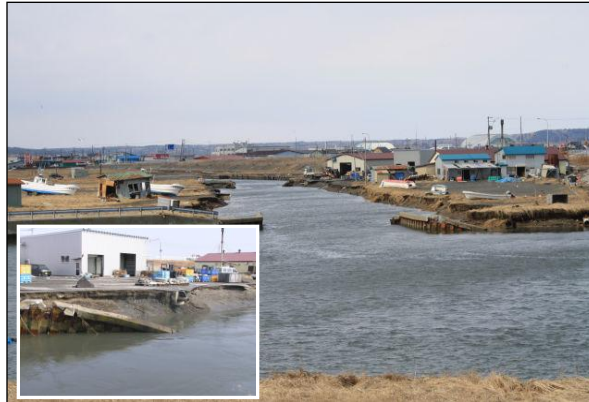
霧多布港 (矢板護岸工の被災状況)
