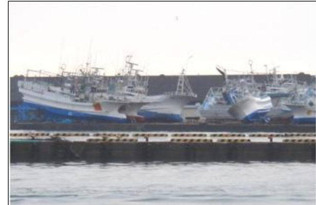
十勝港 (津波による漁船の被害状況)
