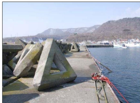
庶野漁港 (消波ブロック散乱状況)
