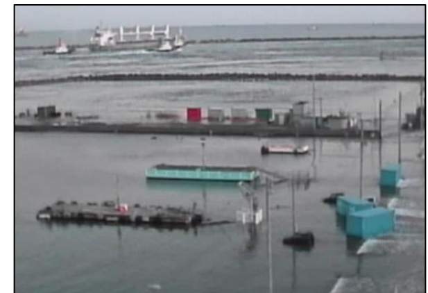
苫小牧港(冠水状況)
