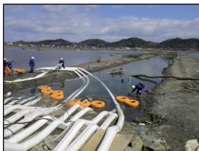
応急対策班 (排水ポンプによる排水作業)
