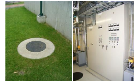
防災井戸とポンプ制御盤
