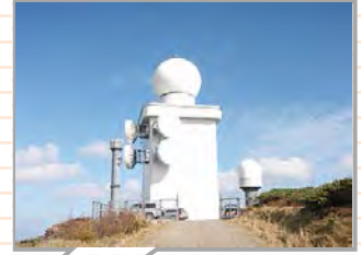
函岳レーダ 雨雪量観測所
