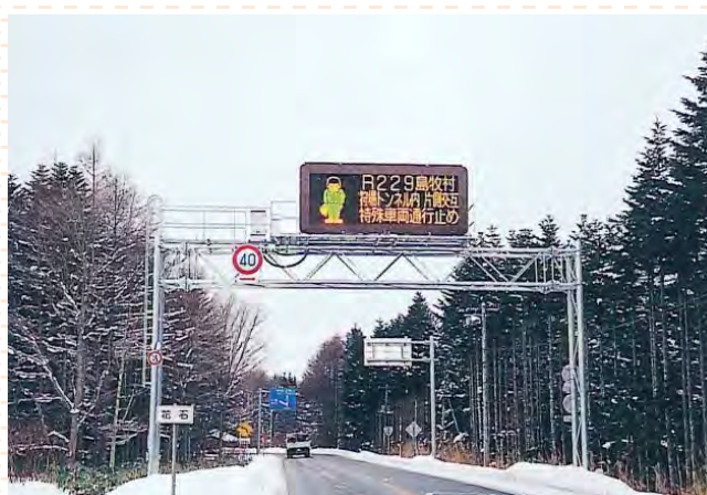
国道 230 号花石道路情報表示装置
