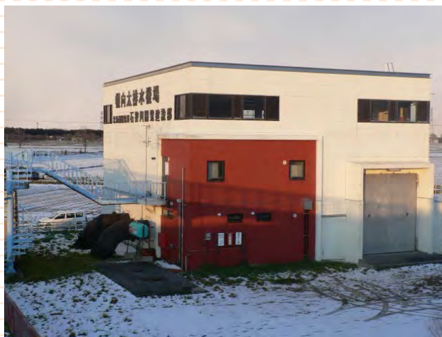
幌向太排水機場
