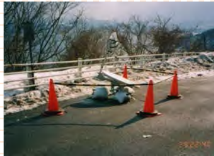
Ku-SAT による画像伝送 平成 12 年 3 月有珠山噴火監視 (国道 230 号 虻田町)
