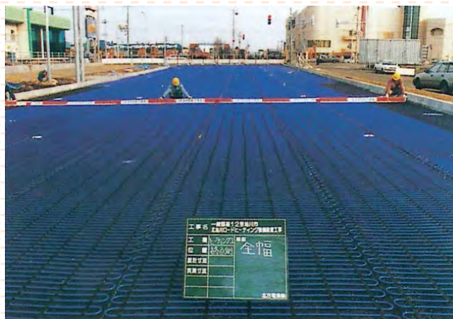
国道 12 号旭川市北旭川高架橋ヒーティング工事
