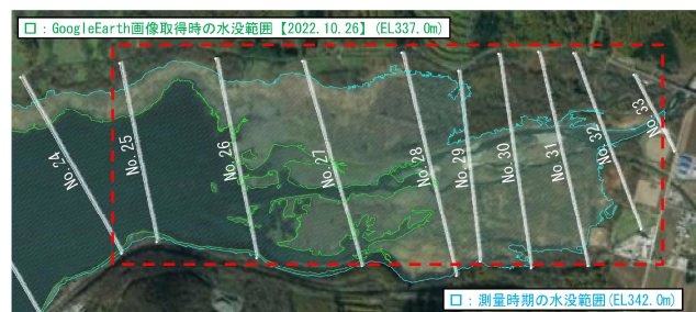
図-2 河川定期横断測量箇所（No.25～No.33）
