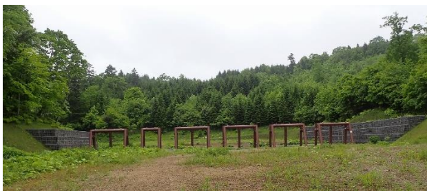
写真-5 鋼製透過型砂防堰堤 （小泉の沢川左支川流木捕捉工）
