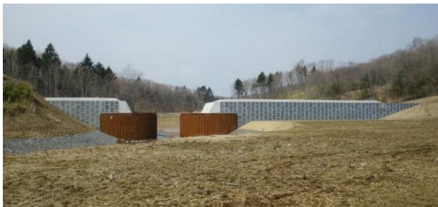
写真-3 鋼製セル+DW 型砂防堰堤（小泉の沢川遊砂地）
