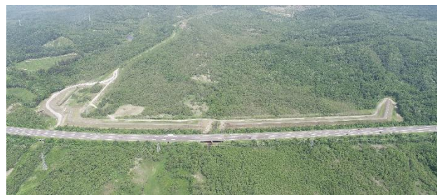
写真-1 土堰堤（苫小牧川遊砂地）
