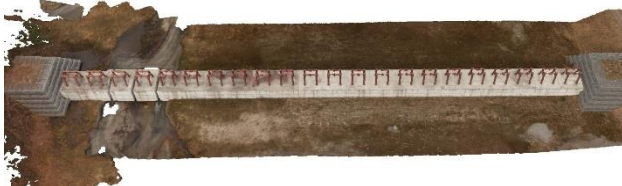
図-14 小糸魚川流木捕捉工:3次元モデル
