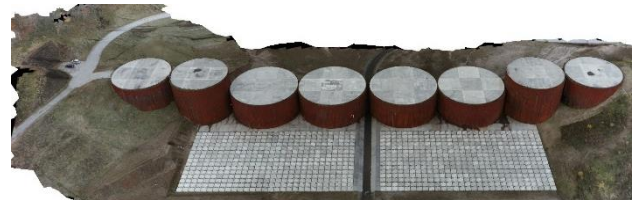
図-16 覚生川 3 号砂防堰堤:3次元モデル
