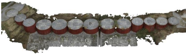
図-10 覚生川1号砂防堰堤:3次元モデル
