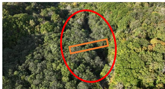
写真4 東御料堰堤における樹木繁茂の状況
