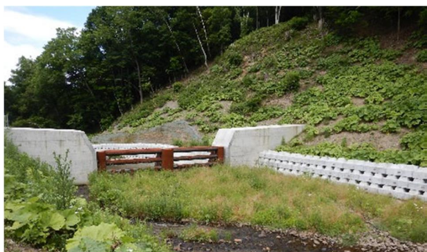
写真1 オカバルシ川透過型堰堤
