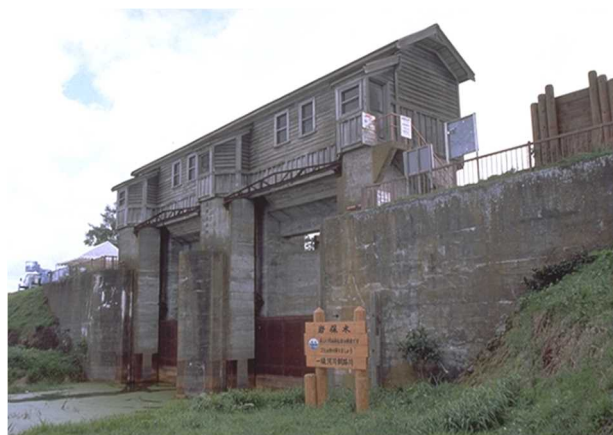
写真-6 旧岩保木水門
