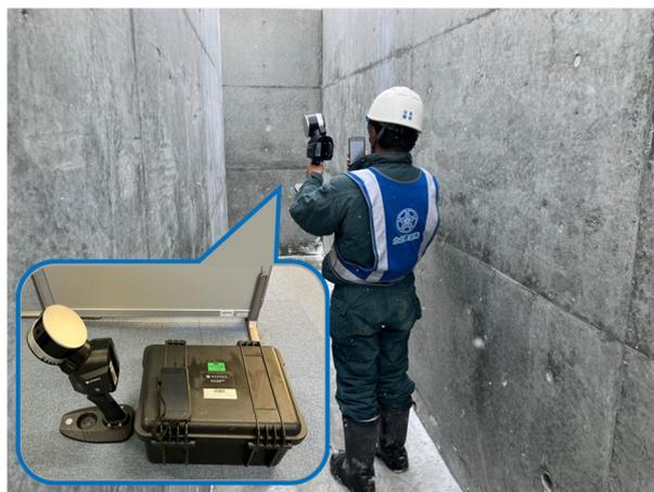
図-7 ハンディスキャナを用いた出来形計測の様子
