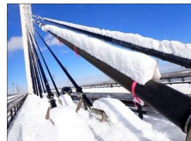
写真19 着雪防止塗装の落雪状況 (左側)
