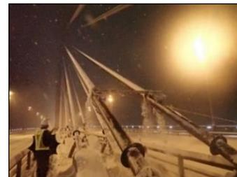
写真7 ケーブル除雪作業状況
