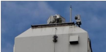
写真4 主塔頂部観測装置状況
