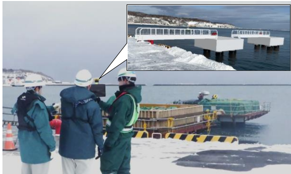
図-5 AR（拡張現実）技術を活用した現場確認
