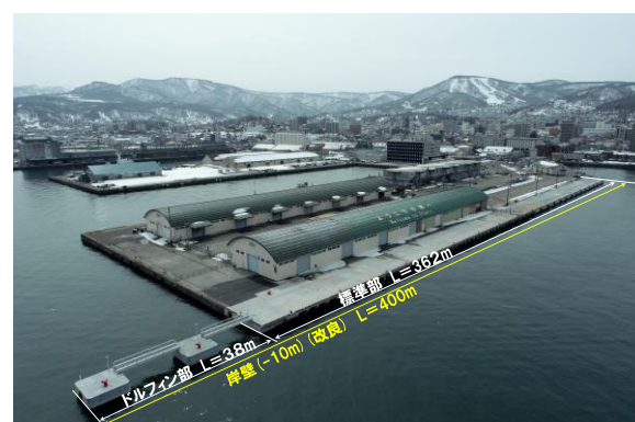
写真-1 第3号ふ頭クルーズ船岸壁
