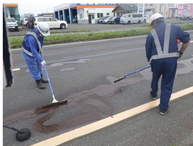
写真-1 ひび割れ部への充填作業
